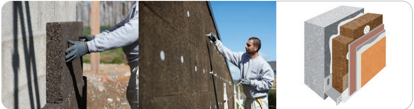
Le système ITE webertherm XM natura intègre panneaux de liège biosourcés, sous-enduits à la chaux aérienne et un large choix de finitions (aspects et couleurs) conjuguant confort intérieur et esthétique extérieure. Sa mise en œuvre traditionnelle (collée sur support neuf) respecte les méthodes de travail des artisans poseurs.
